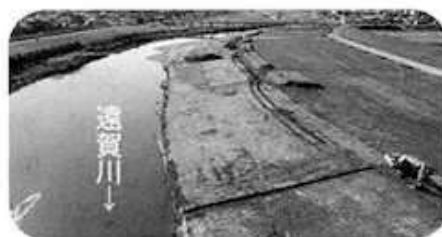
工事实施中(令和3年1月末時点)
