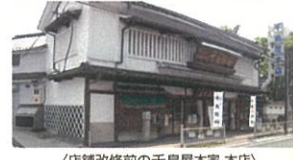
(店舗改修前の千鳥屋本家 本店)
